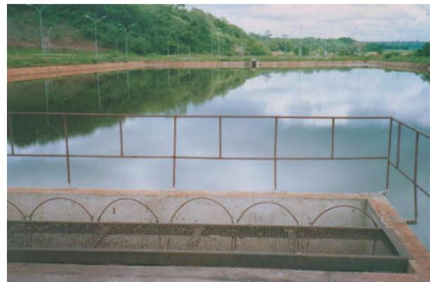
O sistema adotado, lagoa aerada de mistura completa seguida de lagoa de decantação, apresenta algumas vantagens quando comparado com os principais sistemas de lagoas, como construção e operação relativamente simples, maior independência dos fatores climáticos, boa resistência a variações de carga e reduzidas possibilidades de maus odores.
