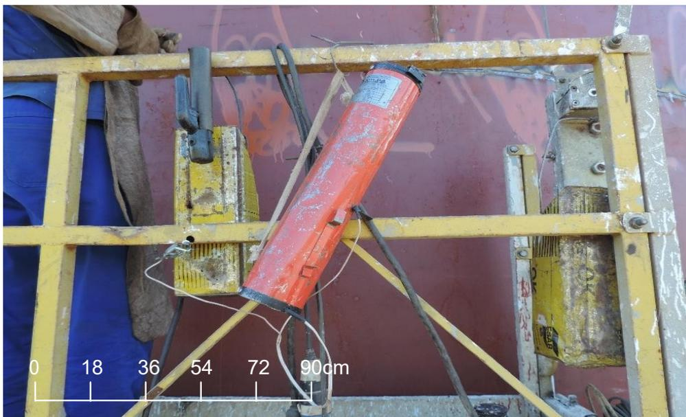
FIGURA 24: Condicionamento adequado dos eletrodos.
