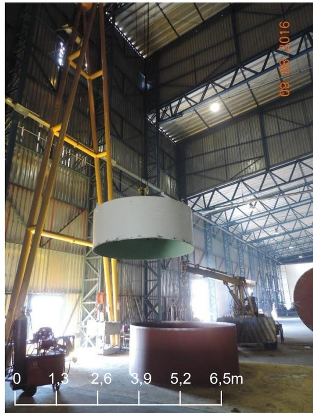
FIGURA 13: Acoplamento vertical dos anéis.
