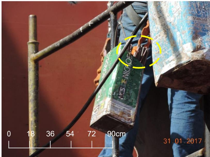
FIGURA 23: Condicionamento inadequado de eletrodos.
