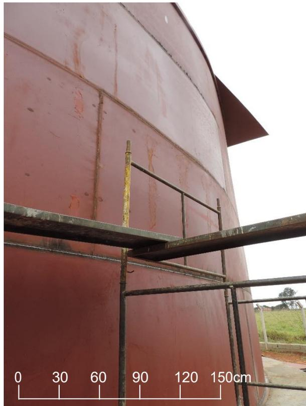
FIGURA 61: Deformações por contrações da solda identificada no RESERVATÓRIO APOIADO 3.
