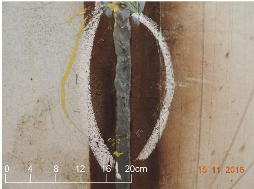
FIGURA 48: Poros por oxidação identificados no RESERVATÓRIO ELEVADO 6.
