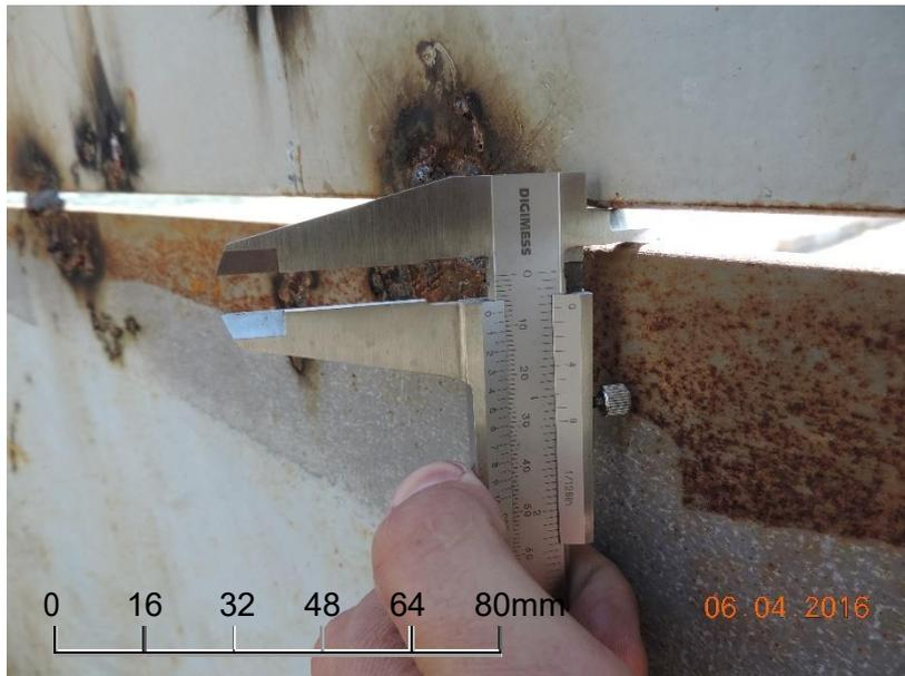
FIGURA 58: Abertura de 7 mm na junta identificada no TANQUE ELEVADO 1.
