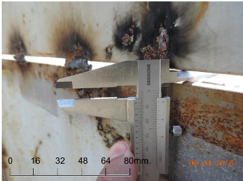
FIGURA 59: Abertura de 7 mm na junta identificada no RESERVATÓRIO ELEVADO 1.
