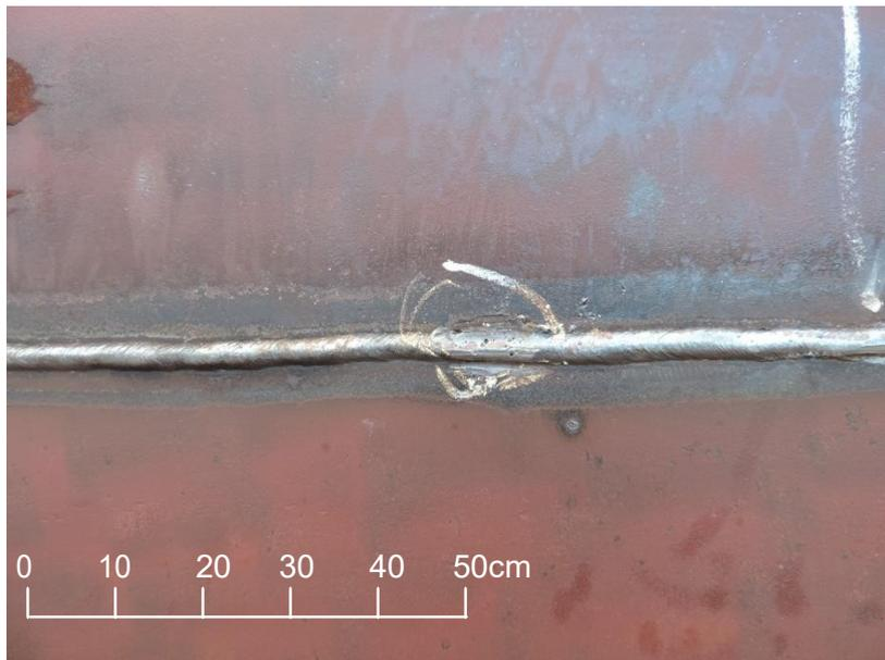
FIGURA 47: Poros em emenda de cordão identificados no RESERVATÓRIO ELEVADO 3.
