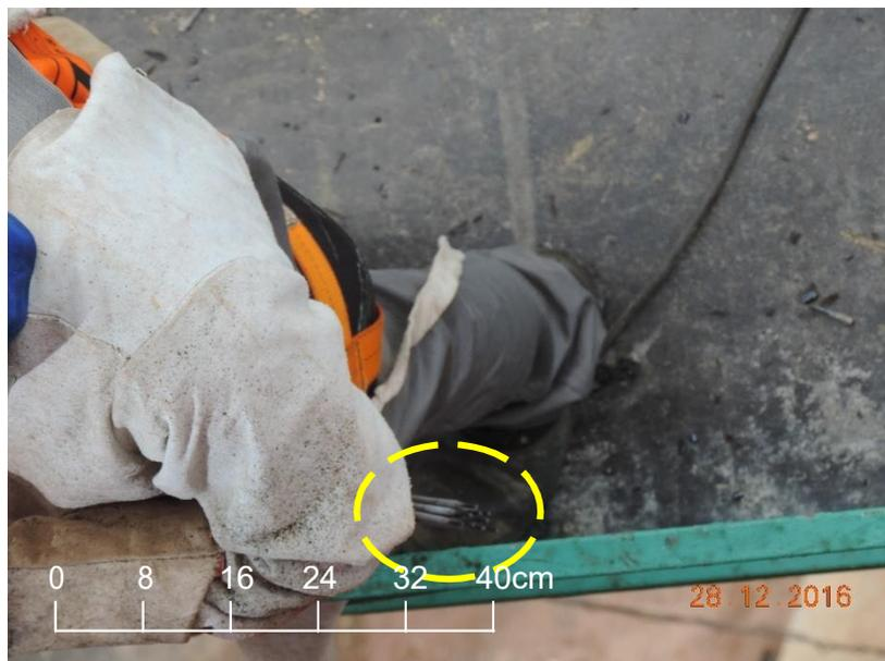
FIGURA 22: Condicionamento inadequado de eletrodos.
